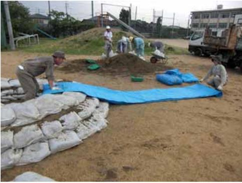
前日準備の様子 校庭に土のう作り資材の搬入と釜段工などを作製
