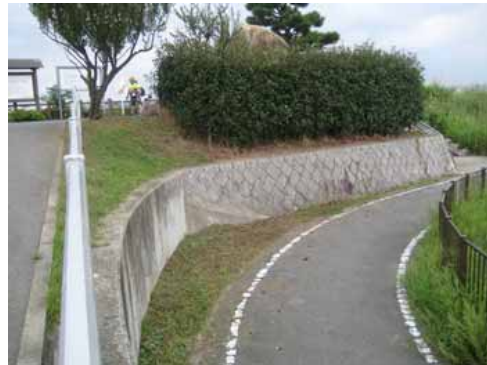
清掃後の側道
