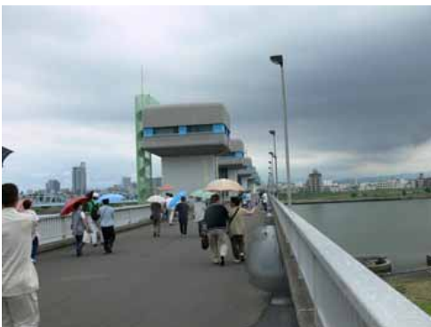
淀川大堰の見学 上からは魚道も見える
