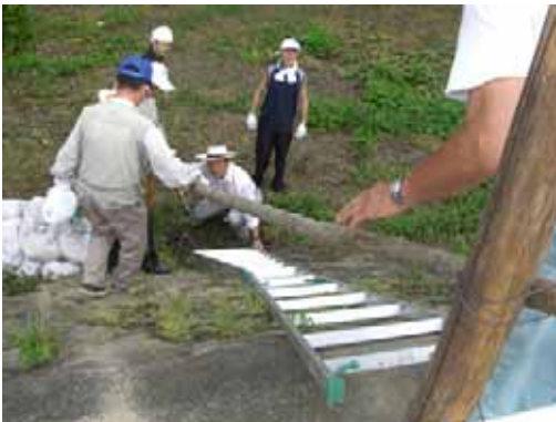
9:49 仮設階段の設置
