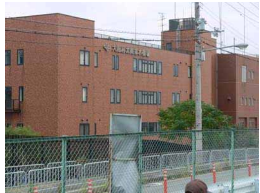
大阪府太間排水機場(民地側)
