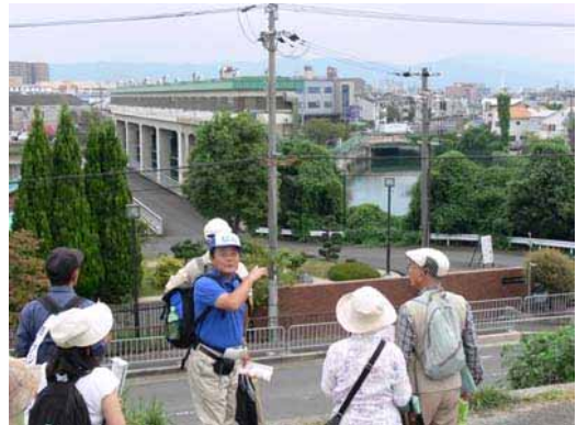
太間排水機場と寝屋川導水路の様子
