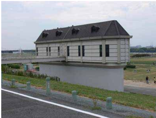
排水塔(河川側)
