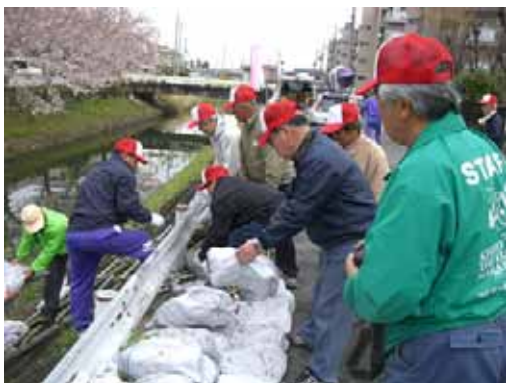
乗下船階段の設営・土嚢による固定
