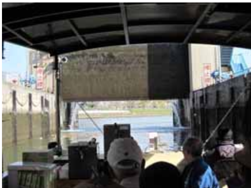
淀川と大川の水位差を調節する為に門が閉じられる様子を閘室から見学
