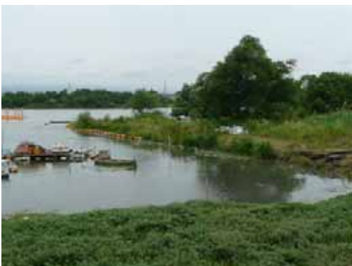
11:39 作業対象エリアの作業後のよう す
