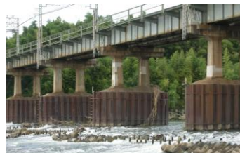
河床低下した現在の近鉄鉄橋
