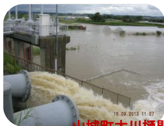
山城町大川樋門
