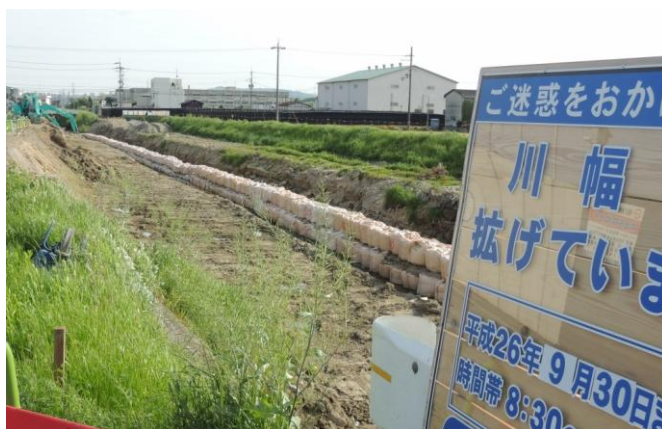
(河川整備計画に基づいた古川の改修工事が進む)
