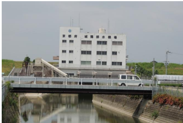
(日頃は見学できない城陽排水機場)
