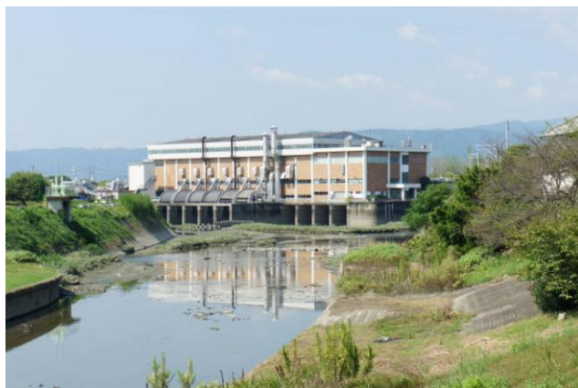
(改修工事が進む古川の久御山排水機場)
