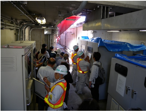
[淀川陸閘見学]
