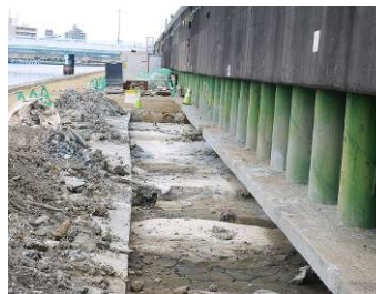
完成後の内部状況
