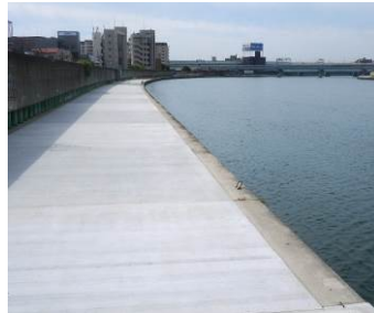
神崎川左岸防潮堤補強工事完成区間
