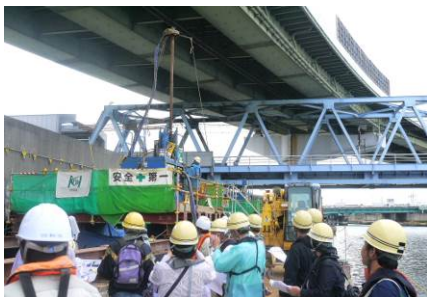
実施状況（改良工事現場での説明）
