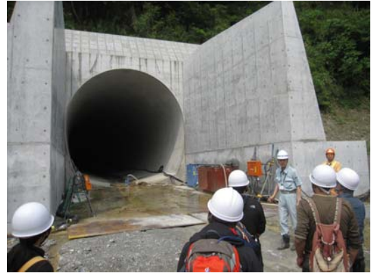
本体工事前に安威川を転流させるバイパストンネル施工現場見学
