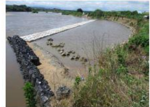
進行中の河岸崩壊復旧工事
