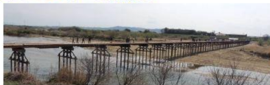
3月に開通した流れ橋(上津屋橋)
